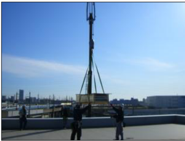
【資材荷揚作業】
