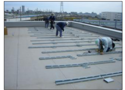
【架台設置作業】
