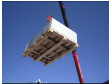
【パネル荷揚作業】
