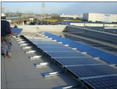
【パネル設置作業】
