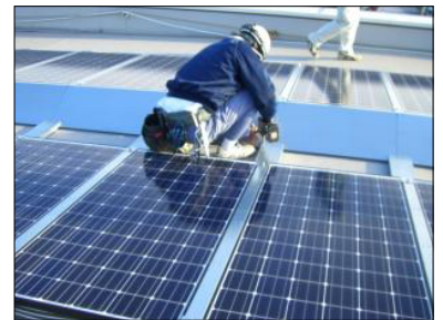
【パネル設置・配線作業】
